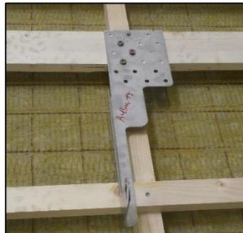
Anschlagpunkt durch die Konterlatte in den Sparren befestigen.
