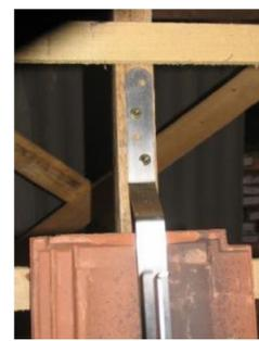
Si nécessaire, «rogner» la tuile inférieure ou supérieure pour assurer le plaquage autour du SIHA MAX PLUS et en permettre le passage optimal.
