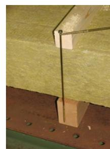
Les points d'ancrage SIHA MAX PLUS se vissent avec 2 vis spéciales Glaro Kombi 8xL... mm (en traversant la contre-latte, l'isolation, le voligeage et en faisant pénétrer les vis dans le chevron sur au moins 100 mm). Utiliser des vis Glaro Kombi plus longues en conséquence et adaptées à la structure. Si le lé de sous-toiture est percé lors du montage, l'étanchéifier conformément aux règles de bonne pratique professionnelle.
