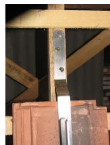
Wenn nötig „Schroten“ des unteren oder oberen Ziegels um den SIHA MAX PLUS flach aufliegen zu lassen und einen optimalen Durchgang zu ermöglichen.
