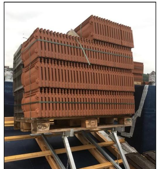
Der Glaromat Ë Palettenträger ist bei korrekter Montage und Beachtung der sicherheitsrelevanten Punkte ungefährlich und ein unverzichtbarer Helfer auf dem Steildach. Bei Fragen zur Verwendung unterstützen wir Sie gerne.
