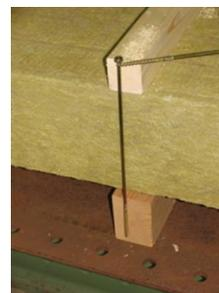
Les points d'ancrage SIHA14 se vissent avec 2 vis spéciales Glaro Kombi 8xL... mm (en traversant la contre-latte, l'isolation, le voligeage et en faisant pénétrer les vis dans le chevron sur au moins 100 mm). Utiliser des vis Glaro Kombi plus longues en conséquence et adaptées à la structure. Si le lé de sous-toiture est percé lors du montage, l'étanchéifient conformément aux règles de bonne pratique professionnelle.
