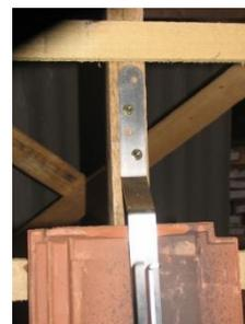
Si nécessaire, «rogner» la tuile inférieure ou supérieure pour en assurer le plaquage autour du SIHA14 et en permettre le passage optimal.
