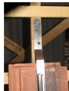
Si nécessaire, «rogner» la tuile inférieure ou supérieure pour en assurer le plaquage autour du SIHA MAX et en permettre le passage optimal.
