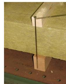
Les points d'ancrage SIHA MAX se vissent avec 3 vis spéciales Glaro Kombi 8xL... mm (en traversant la contre-latte, l'isolation, le voligeage et en faisant pénétrer les vis dans le chevron sur au moins 100 mm). Utiliser des vis Glaro Kombi plus longues en conséquence et adaptées à la structure. Si le lé de sous-toiture est percé lors du montage, l'étanchéifient conformément aux règles de bonne pratique professionnelle.
